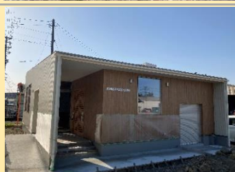
16 中の島コミュニ ティセンター 塩竈市中の島
