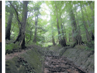
摩耶山の治山遺構
