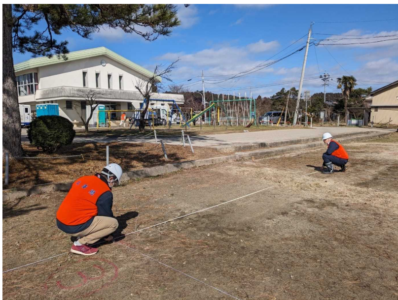
【応急仮設住宅建設支援活動 (珠州市) 2/19】
