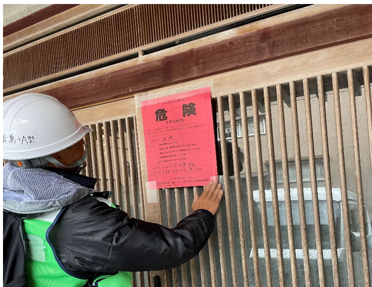
倒壊家屋の応急危険度判定業務(輪島市)
