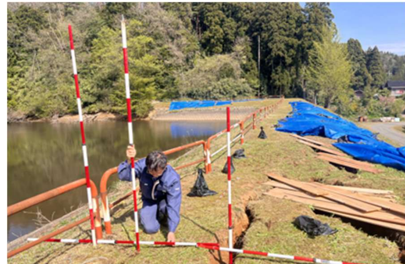
ため池復旧工事測量(珠洲市)
