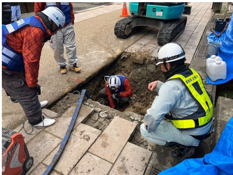
上水道復旧支援(能登町)
