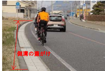
狭隘区間での路肩幅確保
