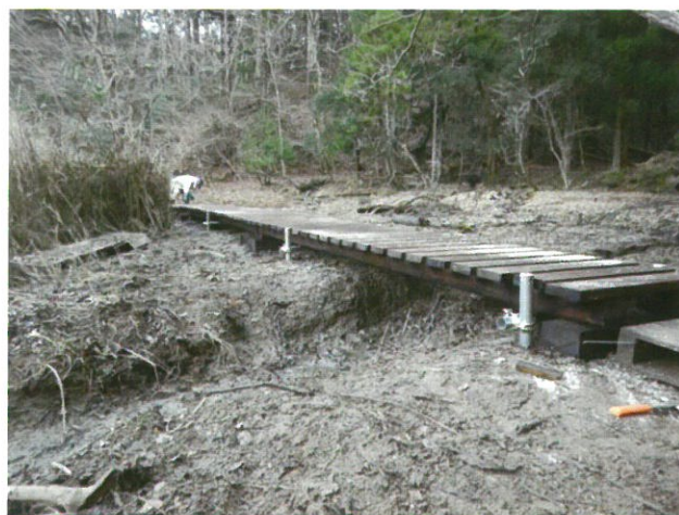
林道の木造橋
