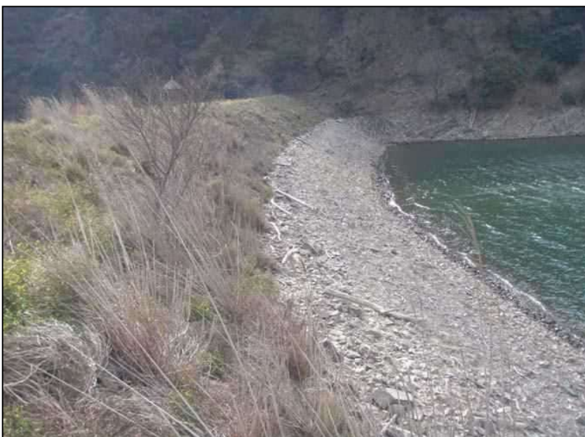
南-58 美女池 堤体後方 水面は下流の大日川ダム
