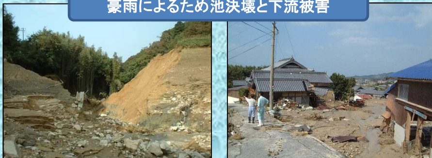
豪雨によるため池決壊と下流被害
