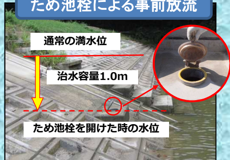
ため池栓による事前放流
