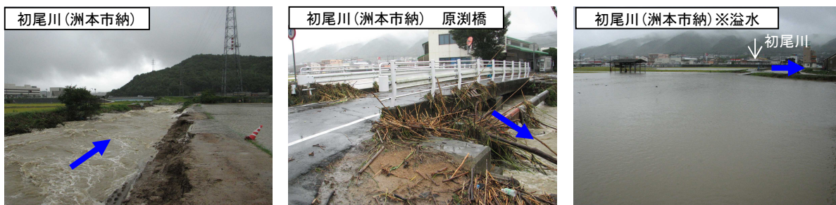
図 1.2.5 平成 23 年台風第 15 号による洪水被害状況
