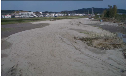
洲本川(上内膳から桑間)※破堤
