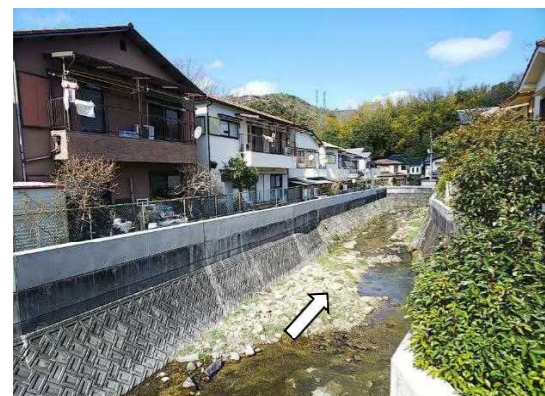
〔③中上流〕名塩川[護岸嵩上げ]（西宮市）
