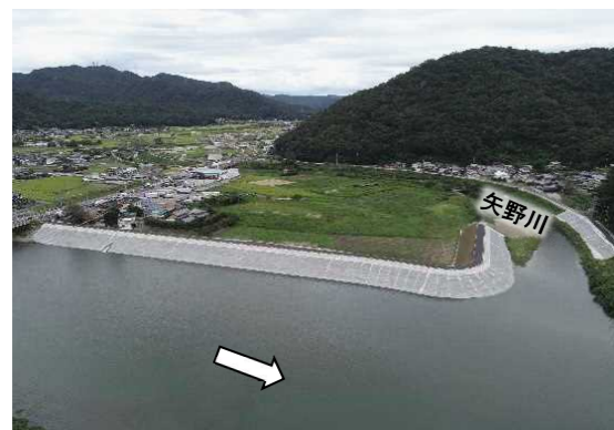
〔①河川改修〕千種川[護岸工]（赤穂市）
