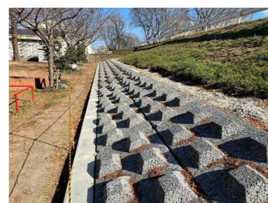
〔④堤防強化〕市川（姫路市）
