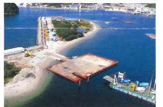
平成30年10月 洲崎工区 仮設栈橋の完成
