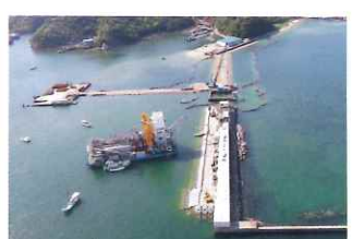
令和2年6月 新設、かさ上げを進める
