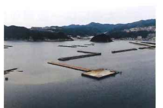
平成31年2月 じゃのひれ側 仮設栈橋
