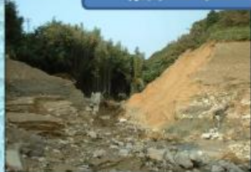
豪雨によるため池決壊と下流被害
