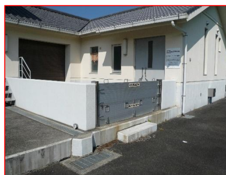
防水板の設置（里・下司地区浄化センター）
