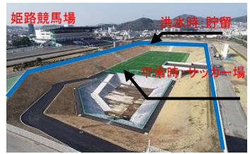
●船場川洪水調節施設
