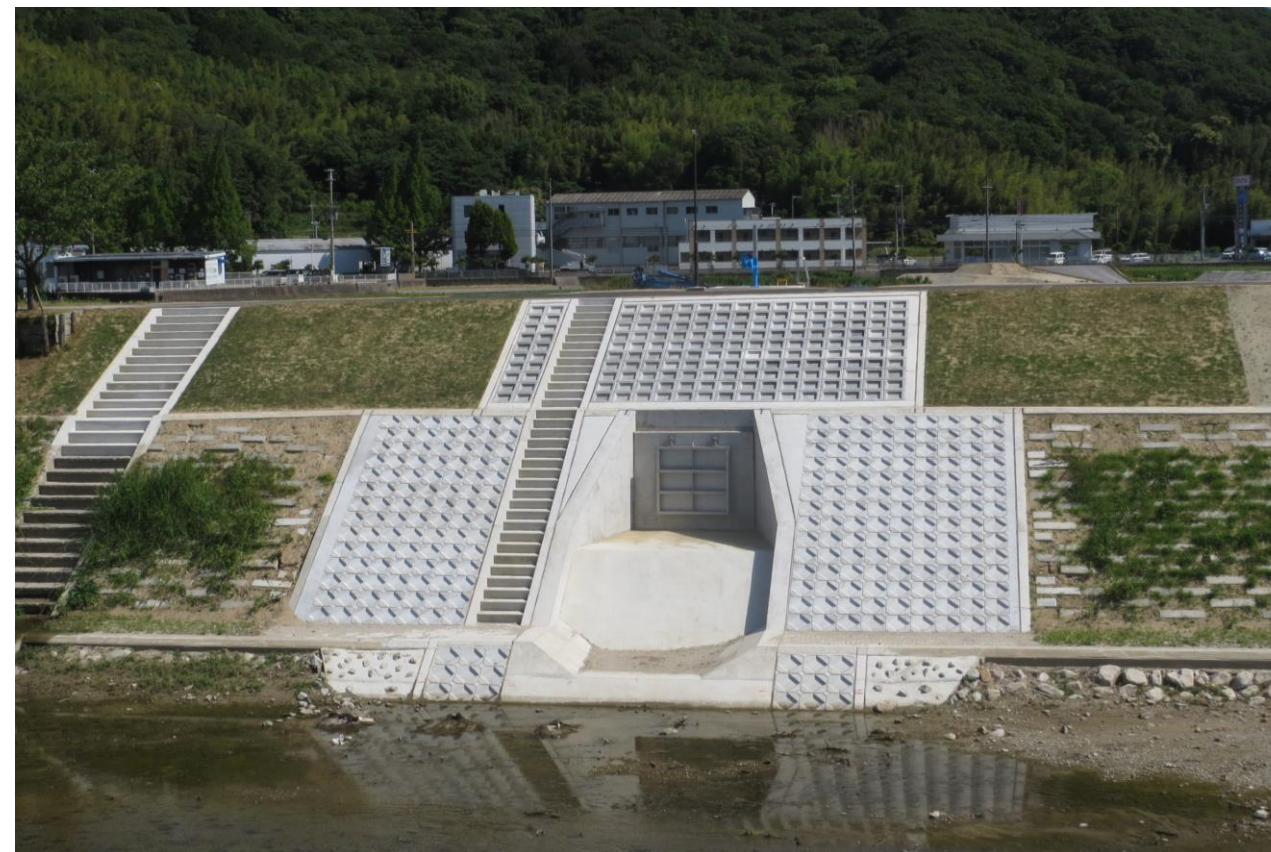
桑間第3雨水幹線の整備（洲本市）
