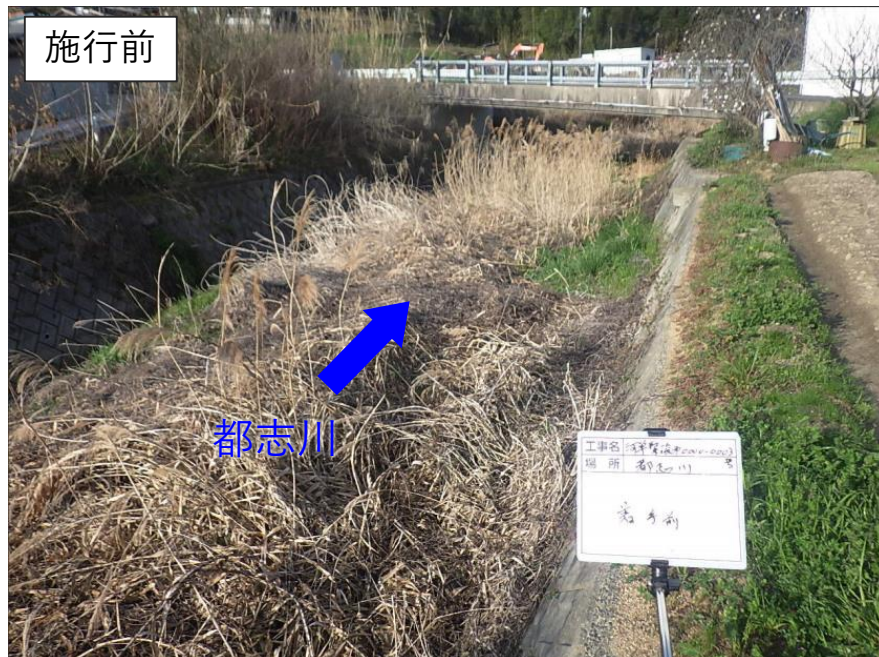
堆積土砂の撤去 【R5実績】6河川 1.3km
