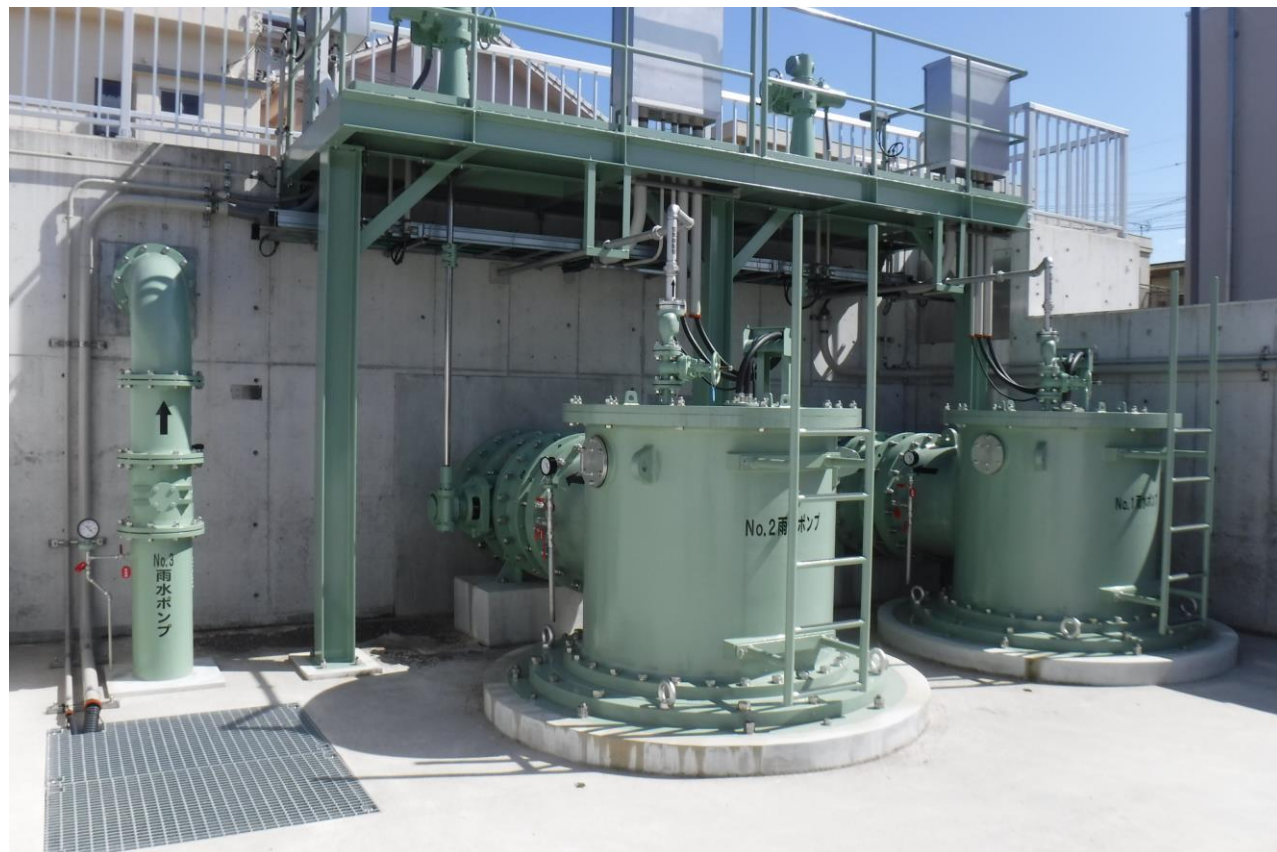
炬口ポンプ場の整備（洲本市）
