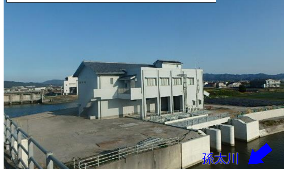
孫太川排水機場 (7.5m 3 /s、更新完了)
