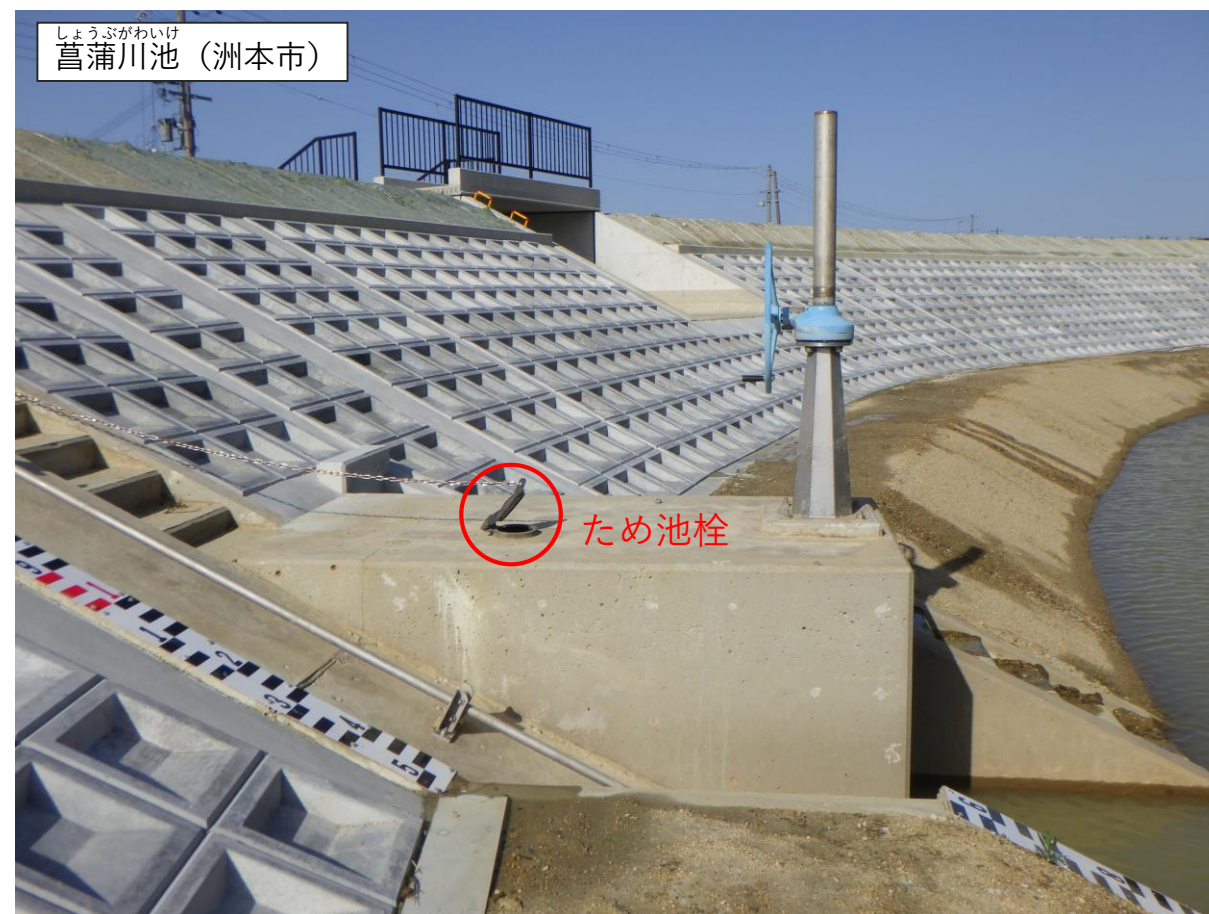
ため池栓の整備
