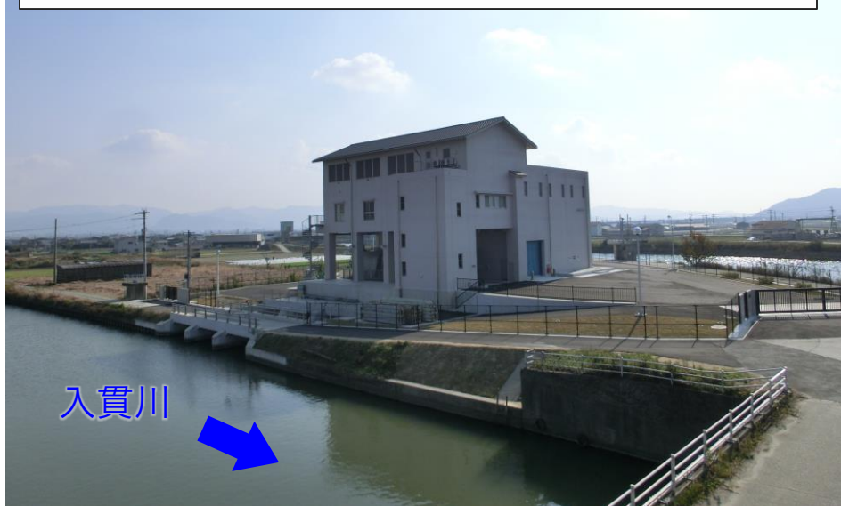
入貫川排水機場 (6.6m 3 /s→16.8m 3 /s、増強完了)
