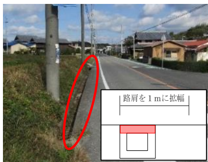
(b 側溝改修)
