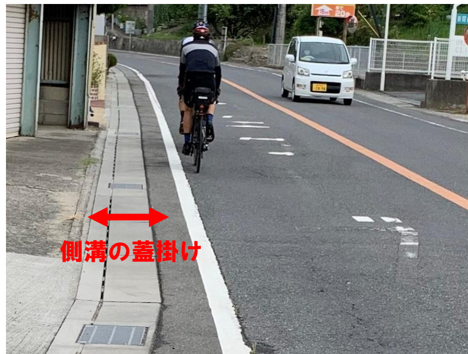
側溝蓋掛け(淡路市育波)
