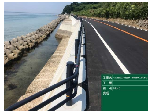
【路肩拡幅(福良江井岩屋線)】
