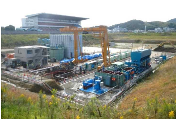
競馬場の内馬場から船場川に向かってトンネルを掘るための基地
