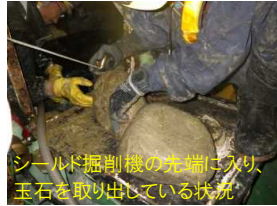
シールド掘削機が緊急停止する前までの入口部分(発進側)の状況
