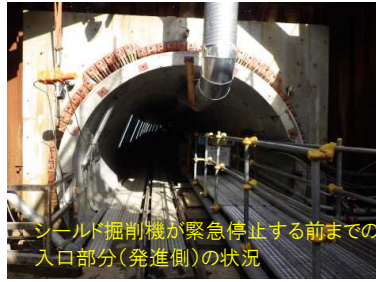
シールド掘削した内部全体を圧気状態にするために入口を改造
