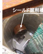
製作直後のシールド掘削機(H28年9月) 到達立坑へ顔を見せたシールド掘削機(H29年6月末)
