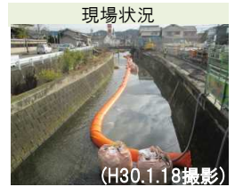
現場状況 (H30.1.18撮影) 河川内の工事作業に先立ち、工事境界部分へオレンジ色の仮締切り材を設置しているところです。今後、川底を掘っていくために、仮締切り材のすぐ横へ土留矢板を打設していく予定です。
