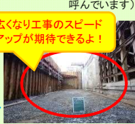
作業空間が広がる土留め方法(グラウンドアンカー式と呼んでいます)
