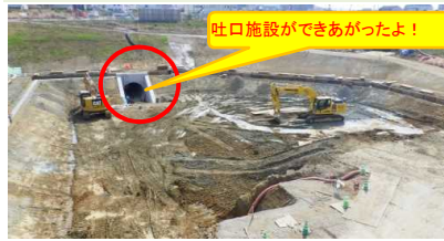
姫路競馬場内の工事現場(H30.4.19時点)
