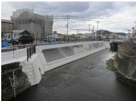
分水施設の工事現場(H30.12.10時点)
