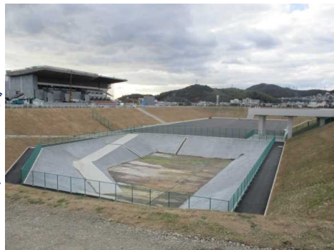
姫路競馬場内の工事現場(H30.12.10時点)
