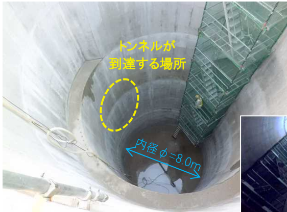
▲ 地下深く完成した到達立坑。 破線円の箇所にて地下導水トンネルが接合する。
