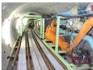
後続には土砂を運ぶ配管が続く
