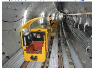
セグメントは門型クレーンで吊り込んで、バッテリー機関車でトンネル先端まで運ぶ
