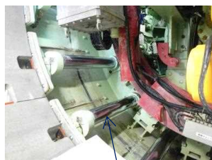
推力用のジャッキが伸びた状態
