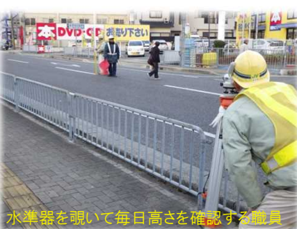
道路の高さの測量は、道路センター(①)と歩道の両端(②③)の計3箇所を20m毎に計測
