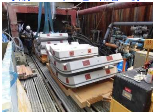
セグメントは門型クレーンで吊り込んで、バッテリー機関車でトンネル先端まで運ぶ
