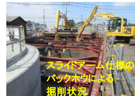
スライドアーム仕様のバックホウによる掘削状況 (H29.9.14撮影)
