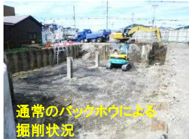
通常のバックホウによる掘削状況 (H29.8.31撮影)
