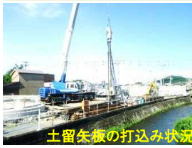
土留矢板の打込み状況 (H29.7.26撮影)
