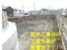
前半工事分の土留矢板が設置完了！ (H29.9.4撮影)
