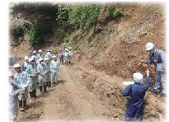
作業道作設 実習
