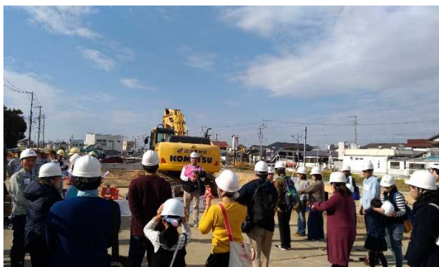
別府川 工事現場
