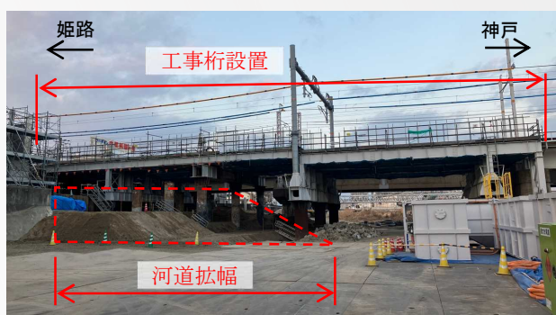
④JR橋梁工区(工事桁設置)
