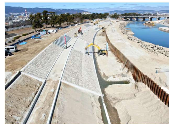
武庫川(西宮市・尼崎市) [河道拡幅]
