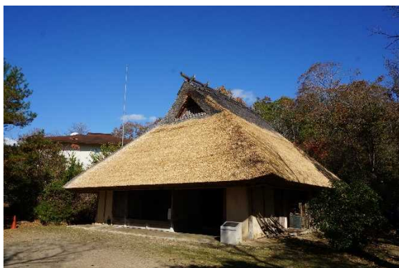
旧東家住宅有形民俗文化財保存修理（屋根葺替）
