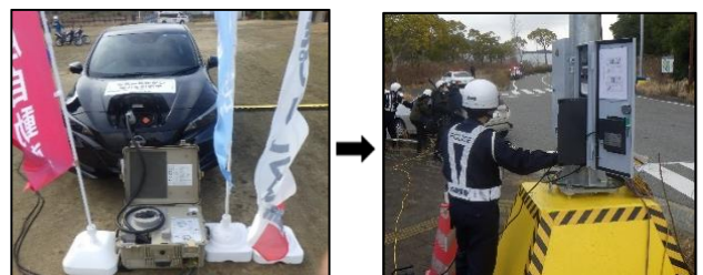
【外部電源による信号機への電源供給】
