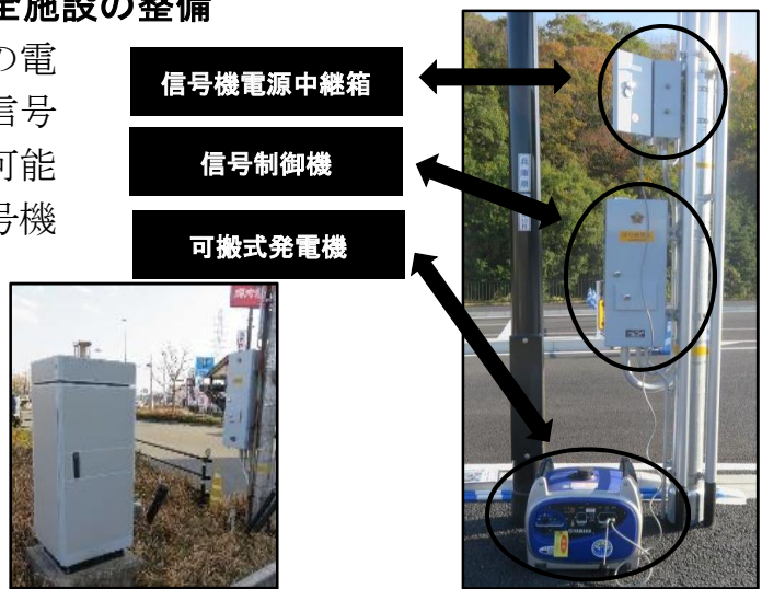
【自動起動式信号機電源付加装置】 【信号機電源中継箱接続状況】
