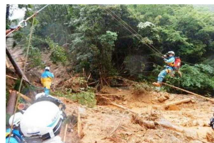
【土砂災害現場での活動状況】
