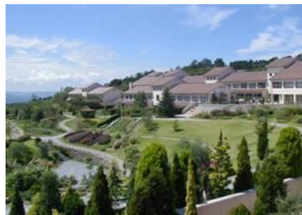
県立淡路景観園芸学校全景
