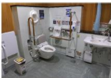
（車椅子使用者用便房） ※通常より広く、手すり等が設置
