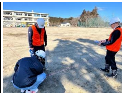
応急仮設住宅建設支援の様子
