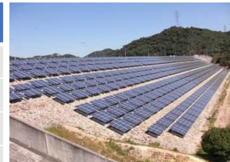
【権現ダム堤体法面】
