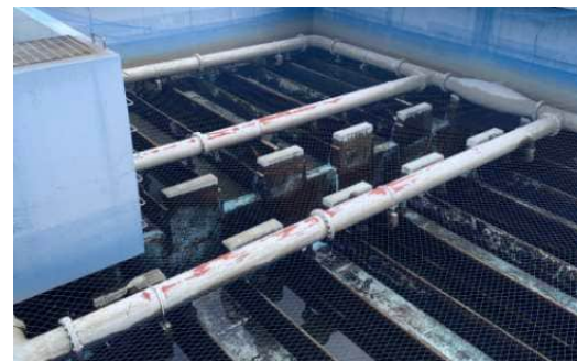
【神出浄水場 1系ろ過池設備更新工事】
