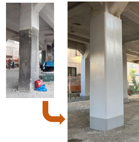
【柱の補強(イメージ)】
