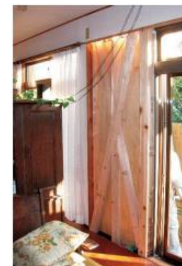
写真1 耐震改修（筋交い補強）
