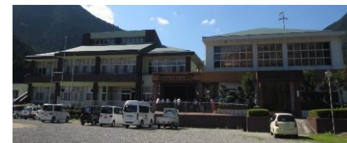
写真4 廃校校舎を活用したサ高住 (Resort by Inn 神河)
