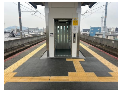
写真3 エレベーター設置 (JR京口駅)
