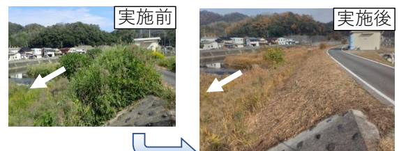
河川堤防の点検前除草（作用町）
