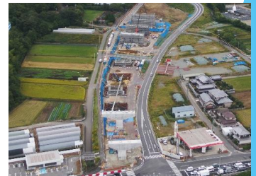
神戸西バイパス（神戸市西区）
