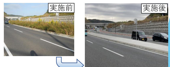
中央分離帯の張りコン（川西市）
