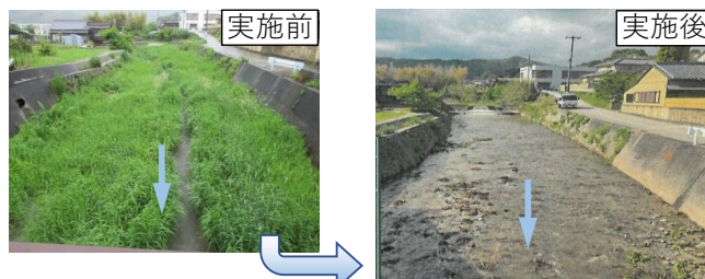
生穂川 堆積土砂撤去（淡路市）
