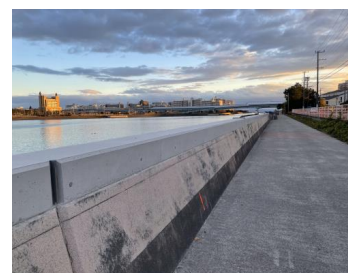
尼崎西宮芦屋港海岸 芦屋浜地区 防潮堤嵩上げ（芦屋市）
