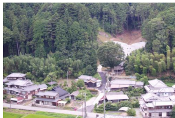
西山川 砂防堰堤（市川町）
