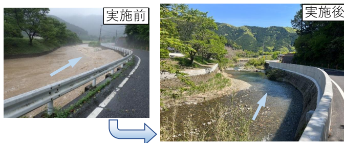
公文川 中上流部治水対策（宍粟市）
