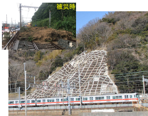
塩屋谷ブロック 斜面对策工（R5年6月完成）
