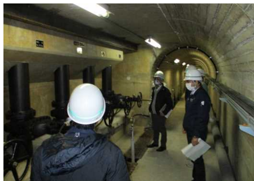
取水ゲート点検 菅生ダム(姫路市)
