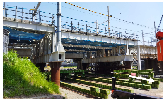
JR 橋梁改築 明石川（明石市）
