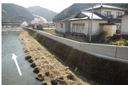
堤防かさ上げ おおやがわ 大屋川（養父市）
