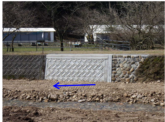
(砂) 二又江川(新温泉町諸寄) 災害復旧工事完成状況
