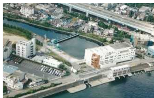
松島排水機場（尼崎市）
