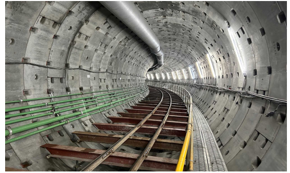
地下貯留管整備 津門川(西宮市)
