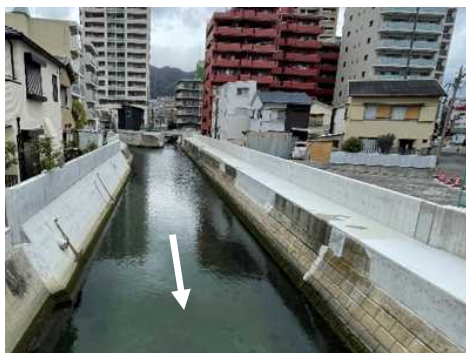
防潮堤のかさ上げ 高橋川（神戸市）
