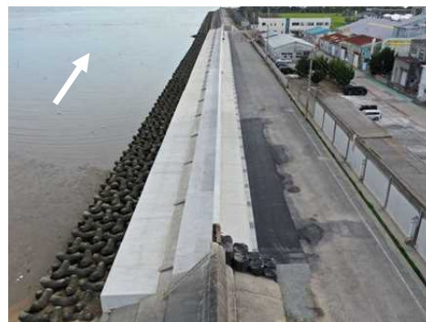
防潮堤の補強 千種川（赤穂市）
