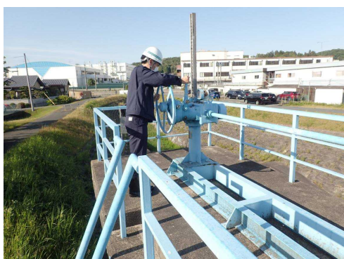
樋門点検 武庫川(三田市)
