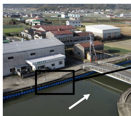
老朽化対策（被覆防食）
