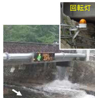
電光掲示板(甲橋) (増水時の状況)
