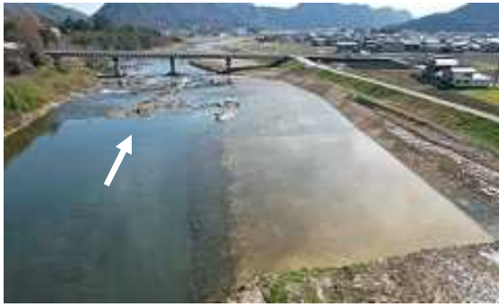
河床掘削 加古川(西脇市)
