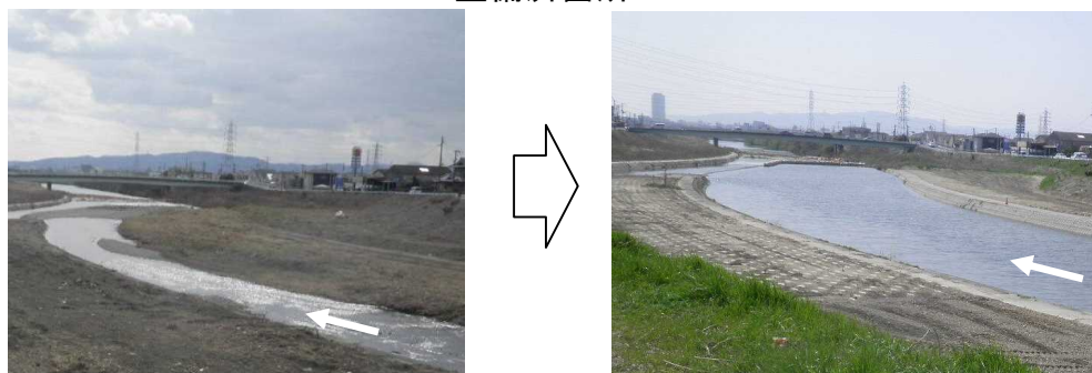
堆積土砂撤去 明石川（神戸市）
