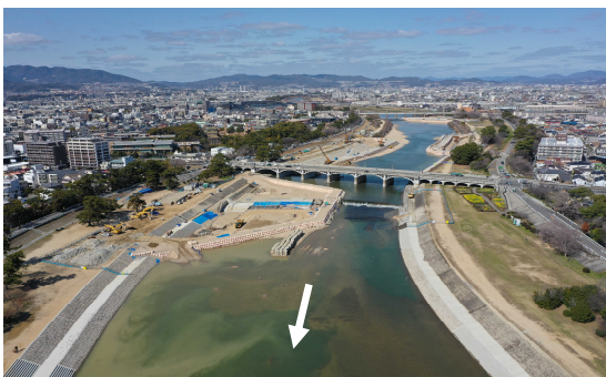
護岸整備、床止改築 武庫川（尼崎市・西宮市）
