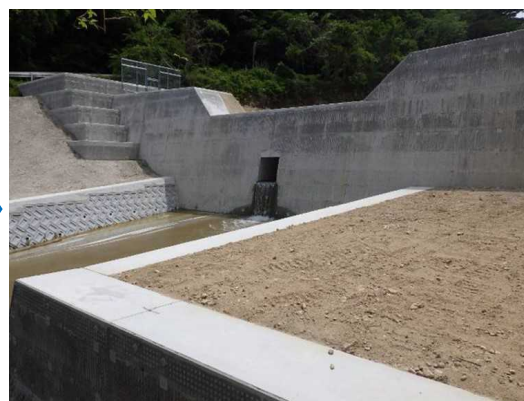
砂防堰堤を改築（増打ち）することにより災害防止機能を向上（対策後）
