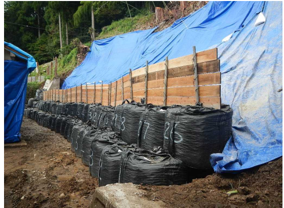
香美町村岡区和田地区 応急工事完了状況
