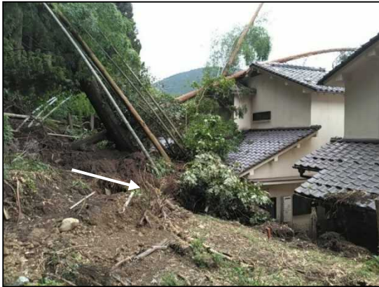
香美町村岡区和田地区 斜面崩壊による家屋被害
