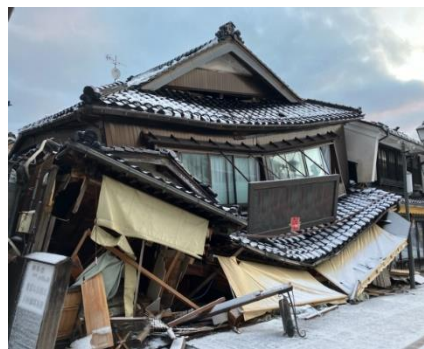
R6 能登半島地震の被害状況
