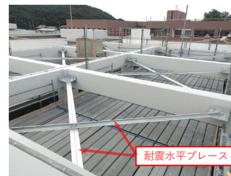
耐震水平ブレース設置等による受変電棟耐震化 （加古川上流浄化センター）
