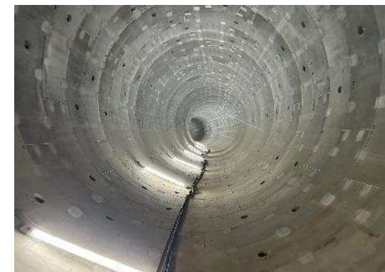
① 地下貯留管整備 津門川(西宮市)
