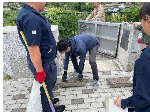
陸閘点検(洲本市)
