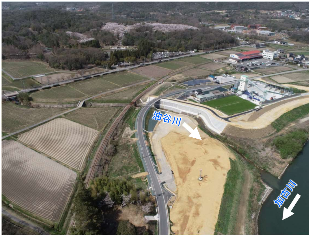
改修状況(県施工区間)
