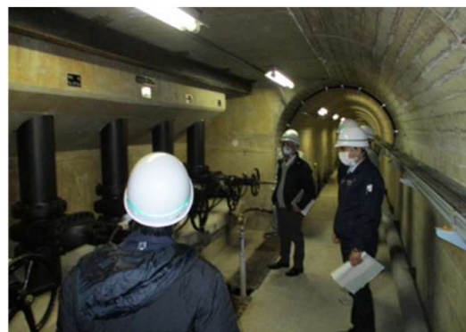
取水ゲート点検 菅生ダム(姫路市)
