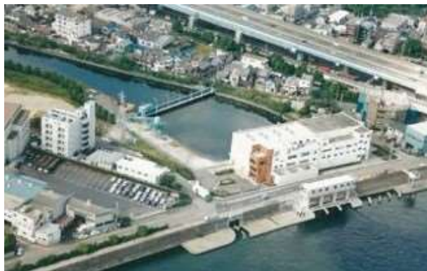
松島排水機場(尼崎市)
