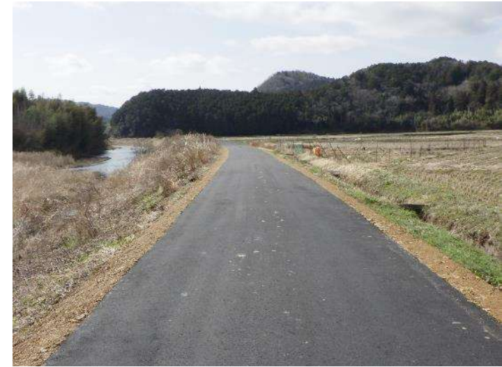
堤防天端舗装
