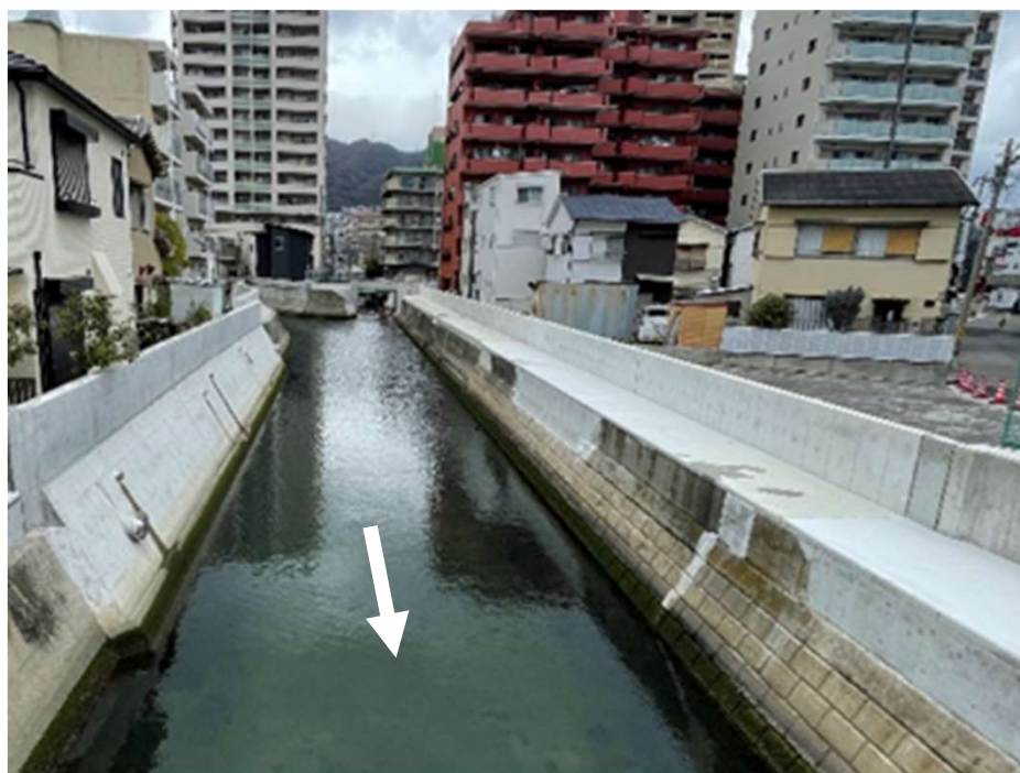
防潮堤の嵩上げ 高橋川(神戸市東灘区)
