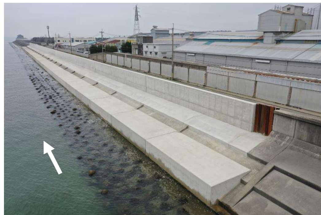
防潮堤の補強 千種川(赤穂市)
