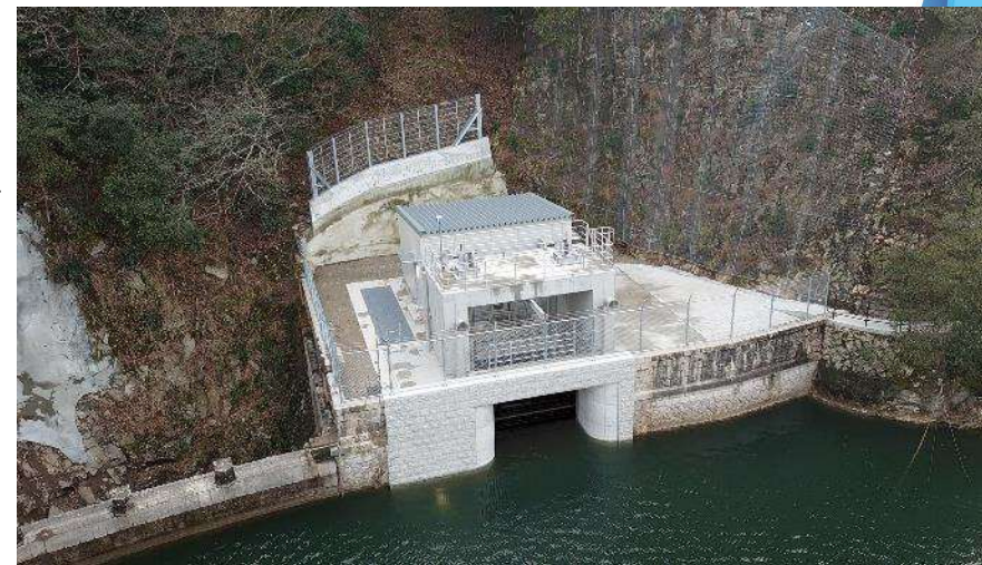
千苺ダム[治水活用放流設備](神戸市北区)
