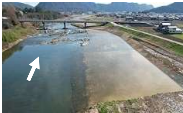
河床掘削 加古川(西脇市)
