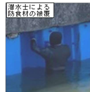
被覆防食の作業状況 入貫川矢板護岸(南あわじ市)
