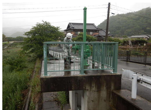
樋門点検(相生市)
