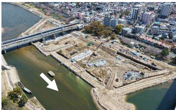
潮止堰撤去 武庫川(尼崎市・西宮市)
