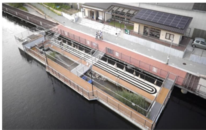
北堀運河（水質浄化施設）
