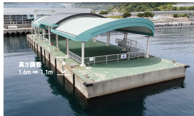
淡路交流の翼港（浮棧橋等・改修）
