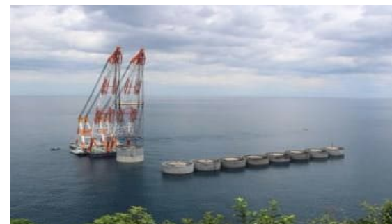
柴山港（防波堤）・新設
