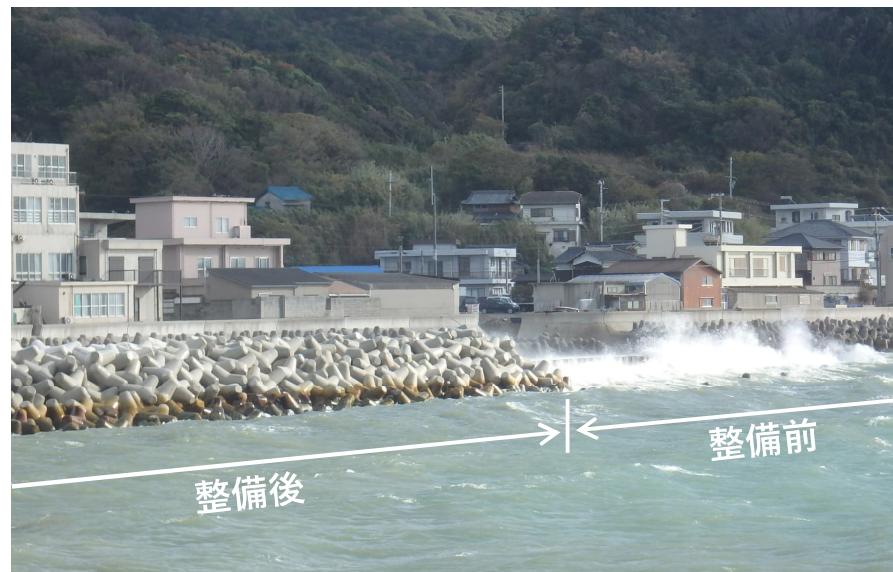
阿那賀組海岸（南あわじ市）・離岸堤整備前後状況
