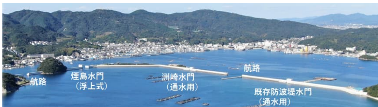
福良港海岸・湾口防波堤（令和6年度完成）
