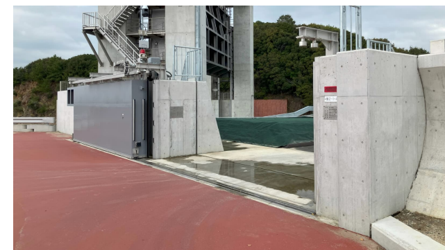
阿万港海岸・陸閘（令和6年度完成）
