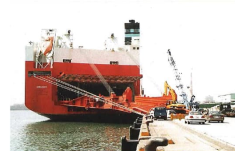
物流 (東播磨港 播磨地区公共岸壁)
