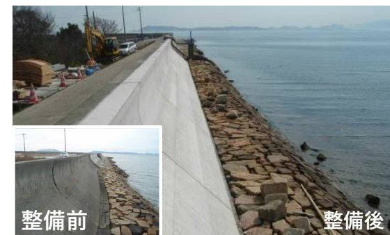
整備前 整備後 御津海岸・護岸補修
