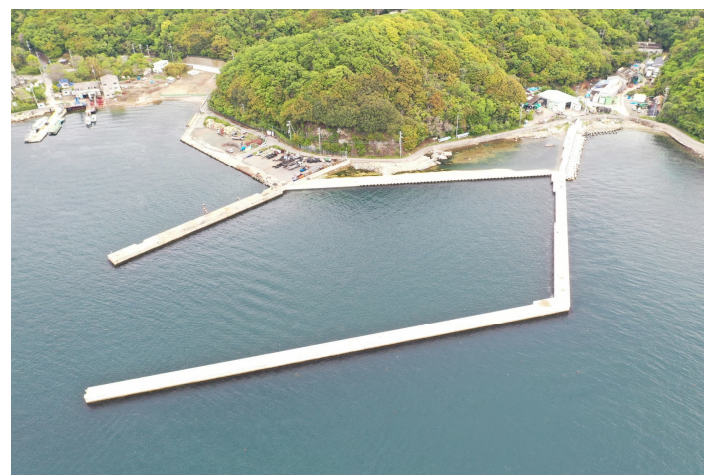
家島港網手地区 物揚場整備
