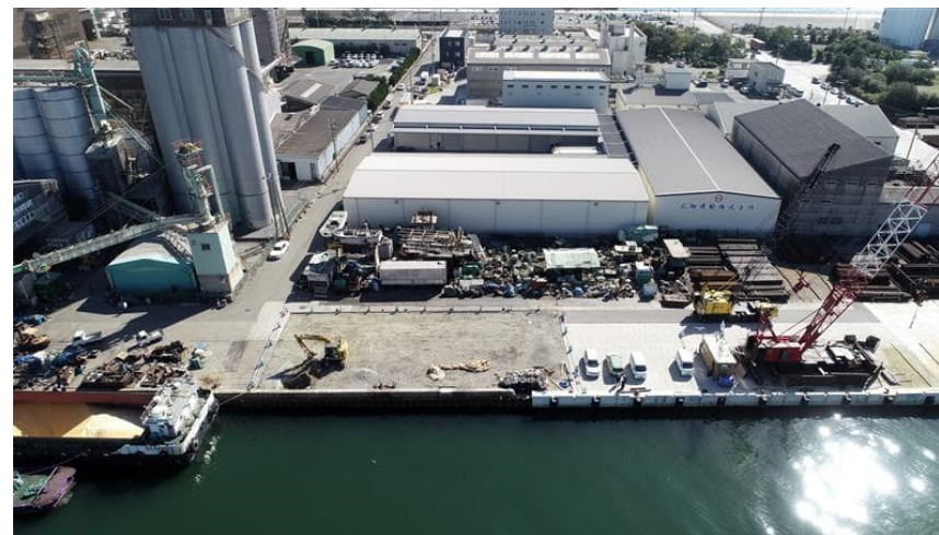
姫路港須加地区（-3.5m物揚場・老朽化対策）
