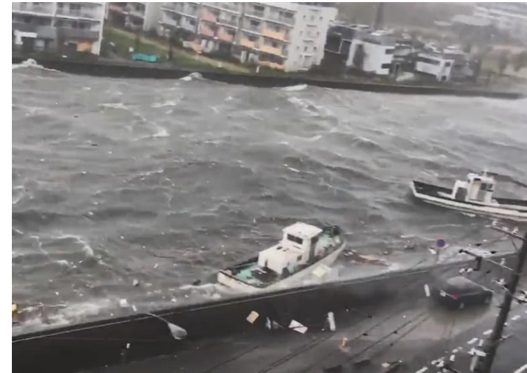
枝川町（西宮市）の越波状況
