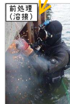
被覆防食の作業状況 入貫川矢板護岸(南あわじ市)
