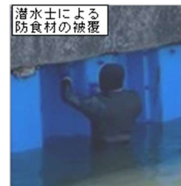
被覆防食の作業状況 入貫川矢板護岸(南あわじ市)
