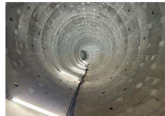
① 地下貯留管整備 津門川(西宮市)
