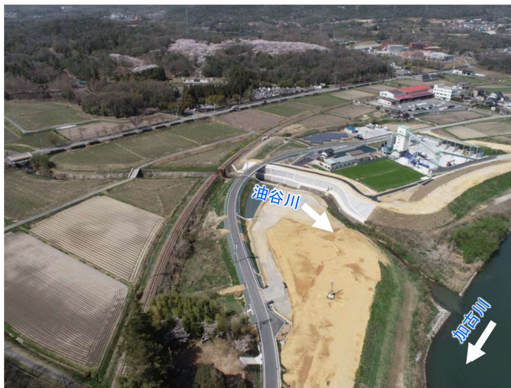
改修状況(県施工区間)
