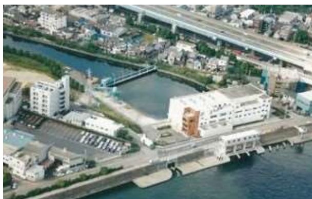
松島排水機場(尼崎市)
