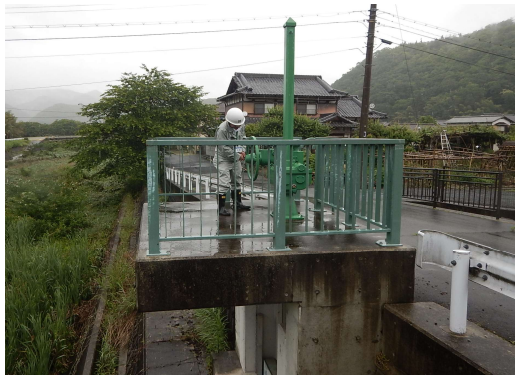
樋門点検(相生市)
