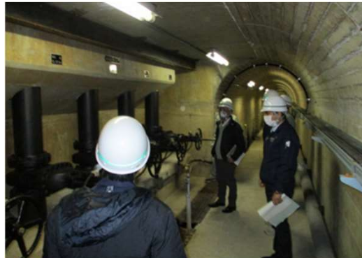
取水ゲート点検 菅生ダム(姫路市)
