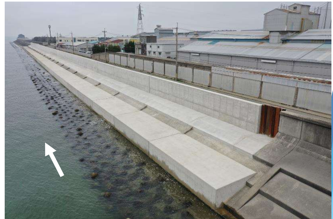
防潮堤の補強 千種川(赤穂市)
