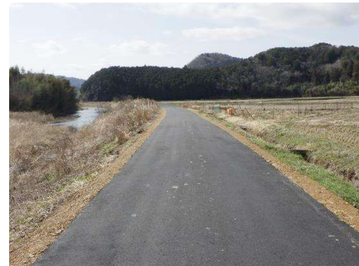
堤防天端舗装
