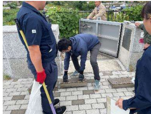
陸閘点検(洲本市)
