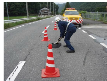
道路パトロールによる路面補修
