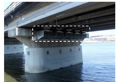
落橋防止装置・橋脚補強 国道 250 号 [汐見橋] (姫路市)
