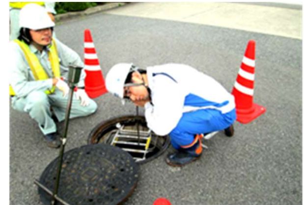
音聴による漏水調査
