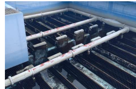
神出浄水場 1系ろ過池設備更新工事
