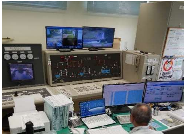
揖保川第2 監視制御設備更新工事
