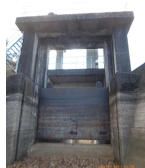
加古川 平荘ダムゲート設備更新工事
