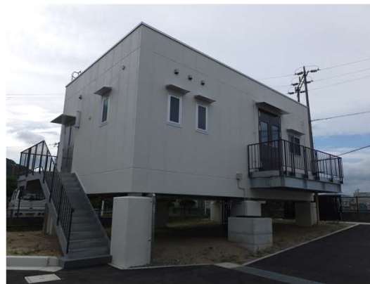
電気設備嵩上げ工事等 (揖保川第2工水第1ポンプ場)
