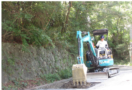
多田浄水場 猪名川幹線管路更新工事
