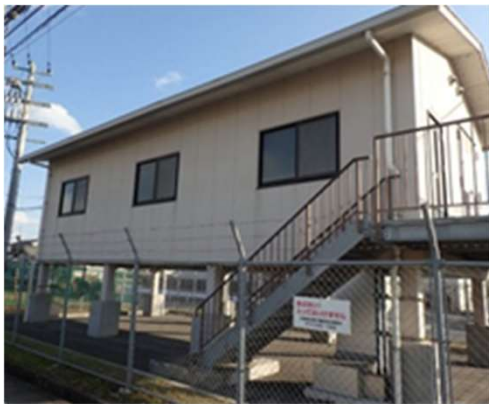
電気棟嵩上げ工事 (揖保川第2工水第2ポンプ場)
