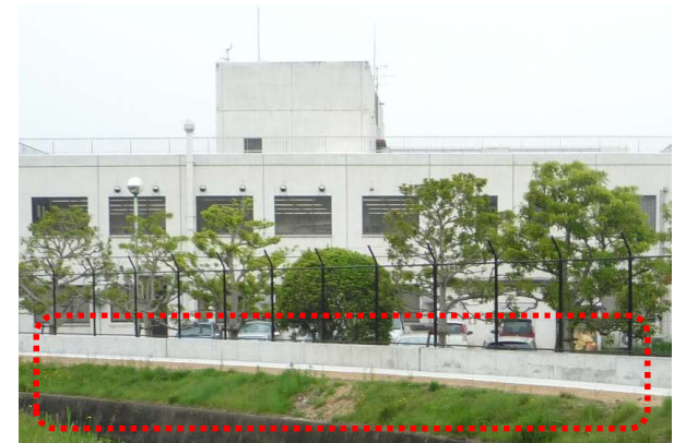
浸水防止用擁壁（船津浄水場）
