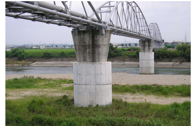
水管橋の耐震補強（加古川横断共同橋）
