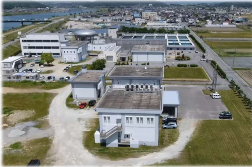
中西条浄水場
