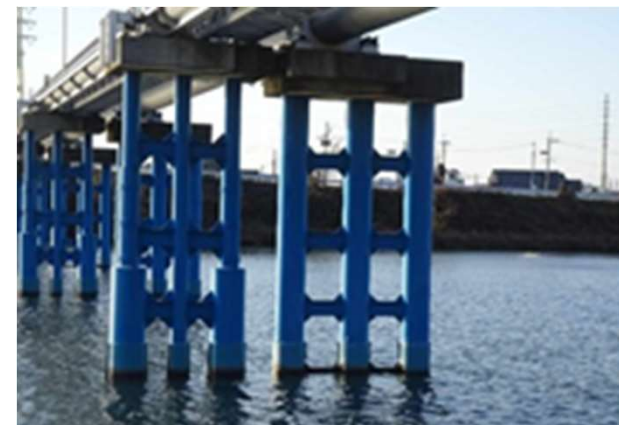
水管橋の耐震補強（市川水管橋）
