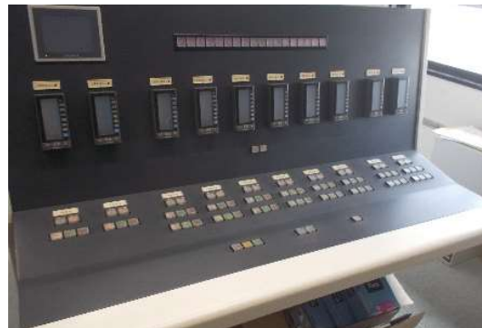
三田浄水場 中央監視制御設備更新工事
