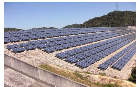
ダム堤体法面の有効活用（権現ダム）
