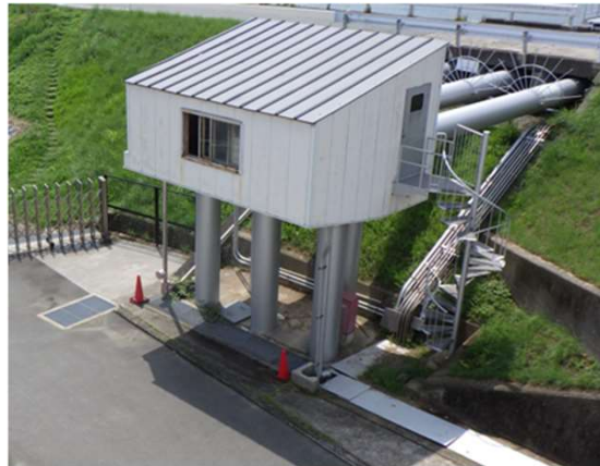
市 川 サイフォン管流量計設置工事
