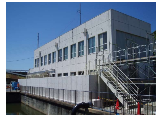
管理棟南面止水壁 (市川ポンプ場)
