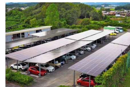
PPA方式による県施設へのカーポート型太陽光発電
