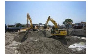
土壌汚染対策の実施現場
