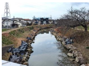
遮光シート設置後
