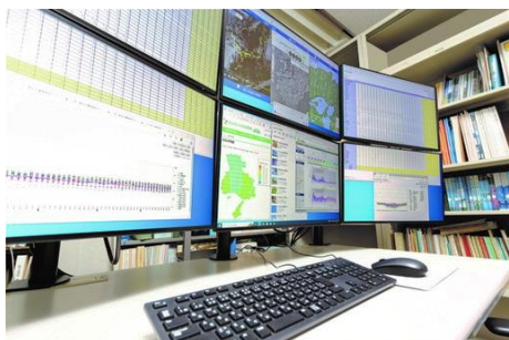
大気汚染常時監視システム
