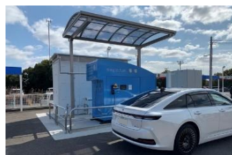
ネットテラス三木 水素ステーション(R6.3開所)
