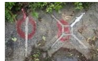
堤防や石垣の目地の隙間から生えないよう樹脂で充填
