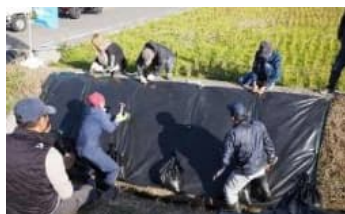
遮光率100%のゴム製遮光シートで繁茂箇所を覆い駆除
