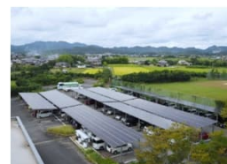
県施設へのPPA方式太陽光発電(加西市)
